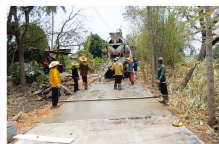
โครงการก่อสร้างถนน คสล. ภายในตำบลชัยชุมพล
