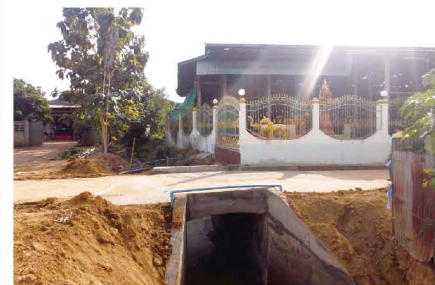
โครงการก่อสร้างท่อเหลี่ยม คสล. หมู่ที่ 1 บ้านน้ำใส จำนวน 2 จุด
