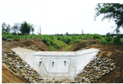
ก่อสร้างฝายน้ำล้นห้วยเคาะ หมู่ 6
