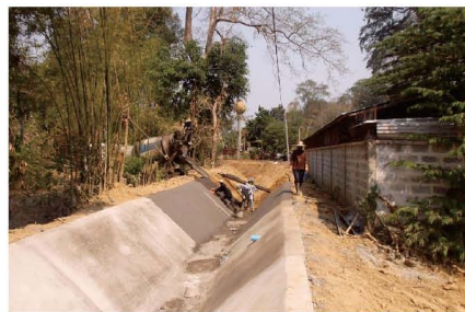
โครงการก่อสร้างลำเหมืองลาดคอนกรีต หมู่ที่ 2 สายทุ่งนายนาง
