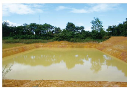
ขุดลอกสระเก็บน้ำหมู่ที่ 1 บ้านน้ำใส
