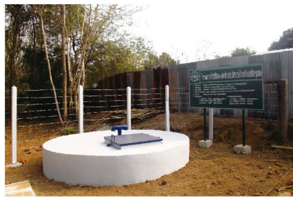
ก่อสร้างถังเก็บน้ำใสเสริมระบบประปา หมู่ที่ 7
