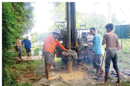
โครงการขุดเจาะบ่อบาดาลภายในตำบล จำนวน 12 จุด
