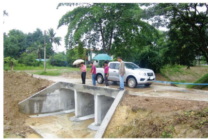
ขุดลอกคลองกลางหมู่บ้าน พร้อมก่อสร้าง ท่อเหลี่ยม คสล.หมู่ที่ 3 บ้านห้องสูง
